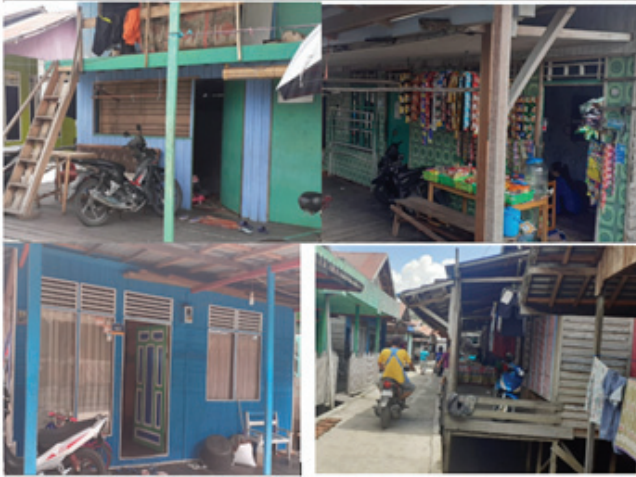
Gambar 4 Kondisi Bangunan Rumah (Sumber : Hasil Survey, 2021)
