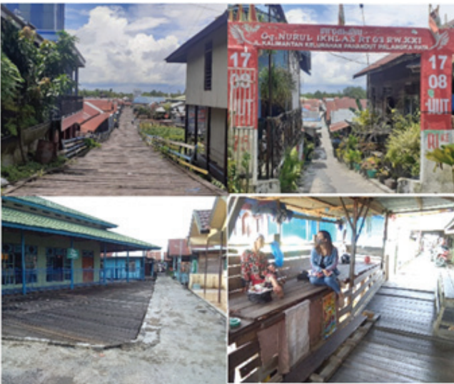
Gambar 5 Kondisi Jalan Lingkungan (Sumber : Hasil Survey, 2021)
